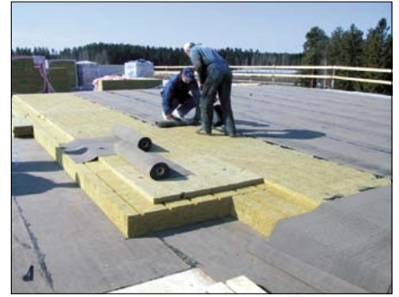
Underlay Roof Slab ja Hardrock
